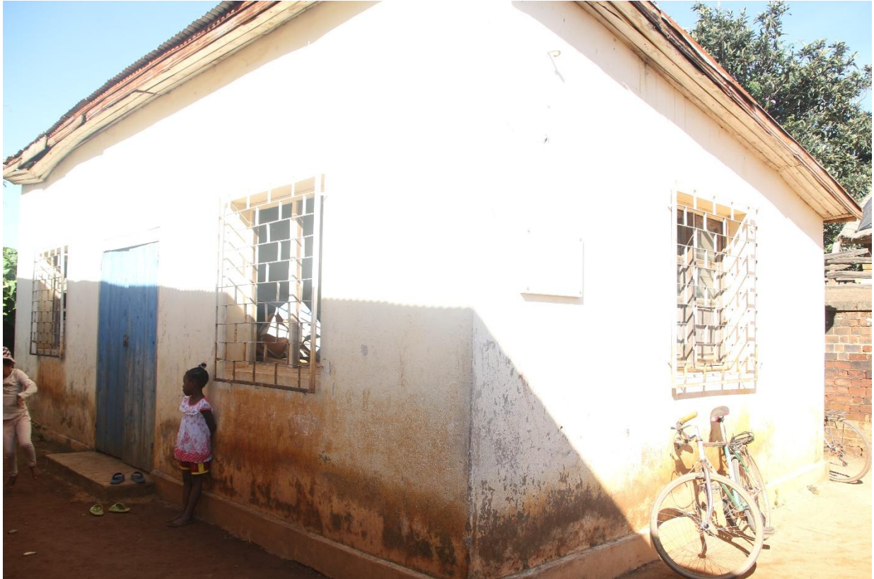
Ancienne bibliothèque qui était prévu être rénové et agrandi pour le réfectoire
